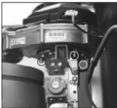
3) Смесителната камера от винтилатора се развинтва (3 бр. вътр. винтове 5мм)
