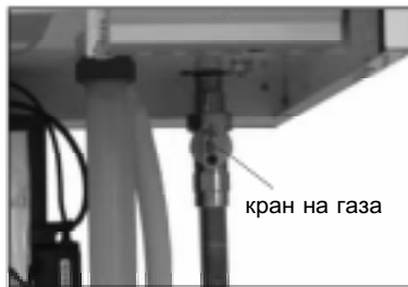
проверка на налягането на газа при връзката
