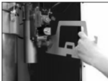
2) Премахва се винта за свързване на газта към комбинирания винтил за газ
