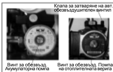
Обезвъздушаване на помпата на отоплителната верига и на акумулаторната помпа
