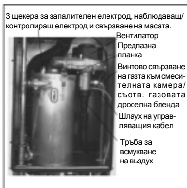
Демонтаж на горелката
