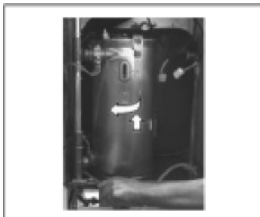
Повдигане и наклоняване навън на горивната камера с помощта на голяма отверка
