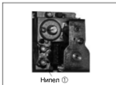
Проверка на налягането на газта при включване
