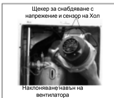
Наклоняване навън на вентилатора
