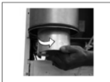
Развъртане в посока обратна на часовниковата стрелка на съда на горивната камера
