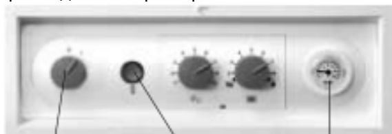
главен шалтер бутон за отстраняване на смущенията/рестарт термометър
